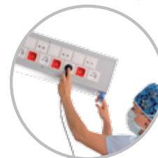
Connexion des câbles électriques
